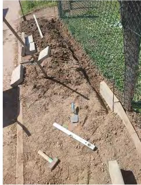
Abbildung 13 Setzen der Kantensteine (KW 18)
