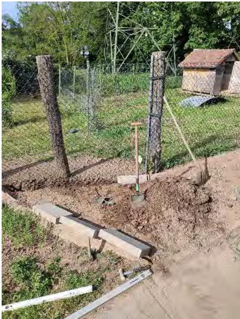
Abbildung 14 Setzen der Kantensteine (KW 19)
