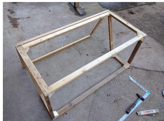
Anschauben der Dachfläche
