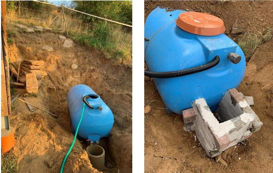
*Abbildung 24 Einsetzen des Wassertanks, eigene Aufnahmen*
